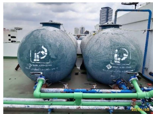
ระบบน้ำใช้ชั้นดาดฟ้าอาคาร A
