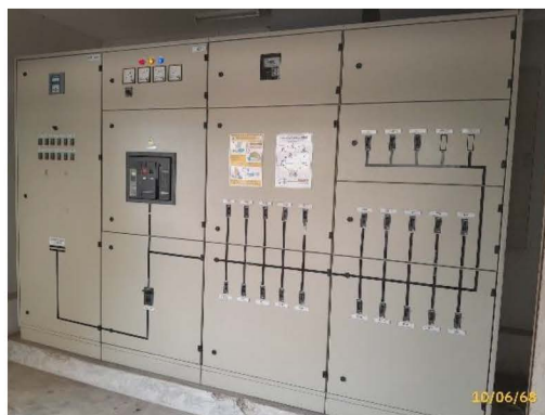
แผงจ่ายไฟฟ้าหลัก
